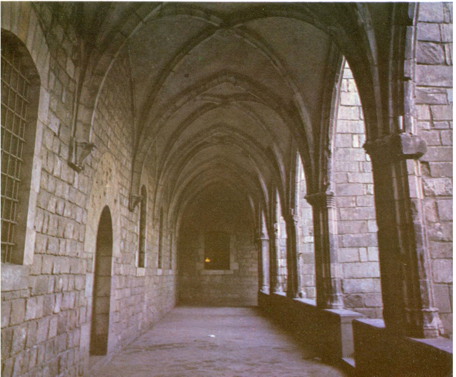
Claustro gótico del antiguo hospital de la Santa Cruz de Barcelona
